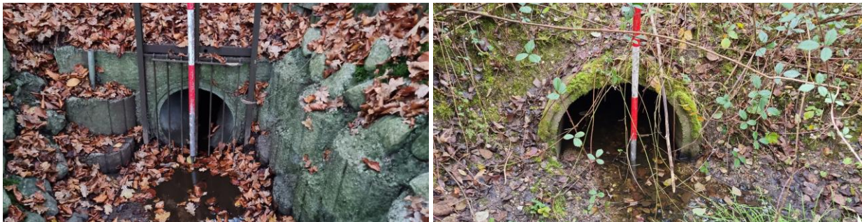
Abbildung 5: Beispiel Ortsbegehung Fotodokumentation. Links: Bahnhofstraße - straßenbegleitender Ableitgraben mit Durchlässen; Rechts: Wildenroth Osten - straßenbegleitender Ableitgraben mit Durchlässen.
