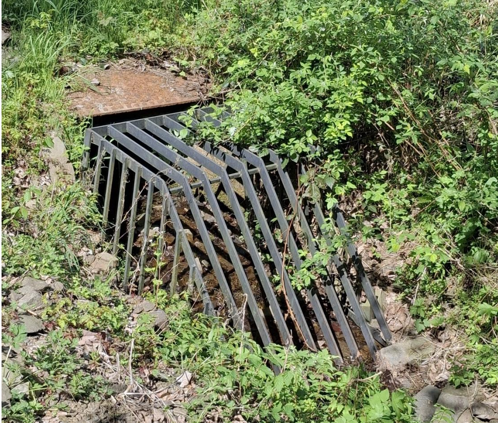
Abbildung 20: Beispiel - Räumlicher Rechen vor einer Verrohrung
