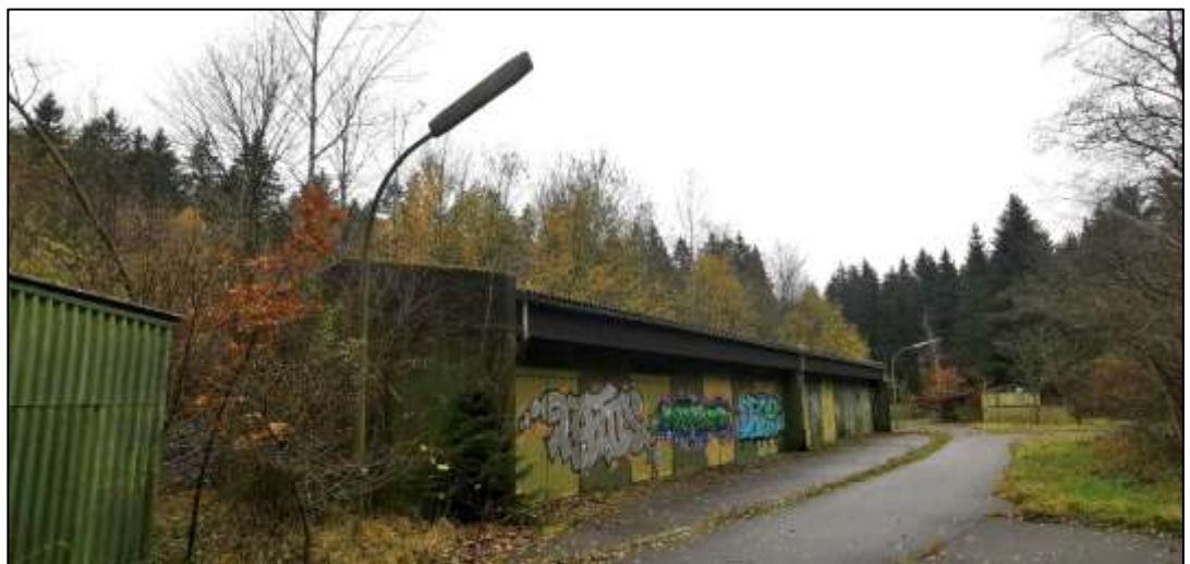
Abb. 4 Blick von Süden nach Norden auf die asphaltierte Zuwegung, das abzureißende Lagergebäude und den Wald im Plangebiet; Quelle: PV; Aufgenommen am 10.11.2025
