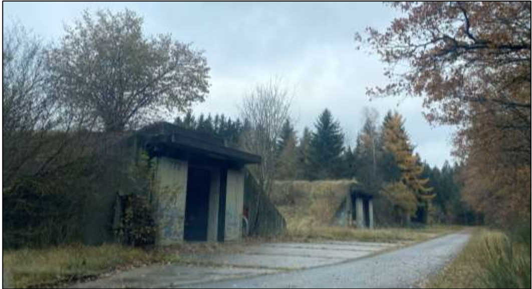
Abb. 2 Blick auf die Bunkeranlagen im Osten, ohne Maßstab, Quelle: PV, Aufgenommen am 10.11.2025
